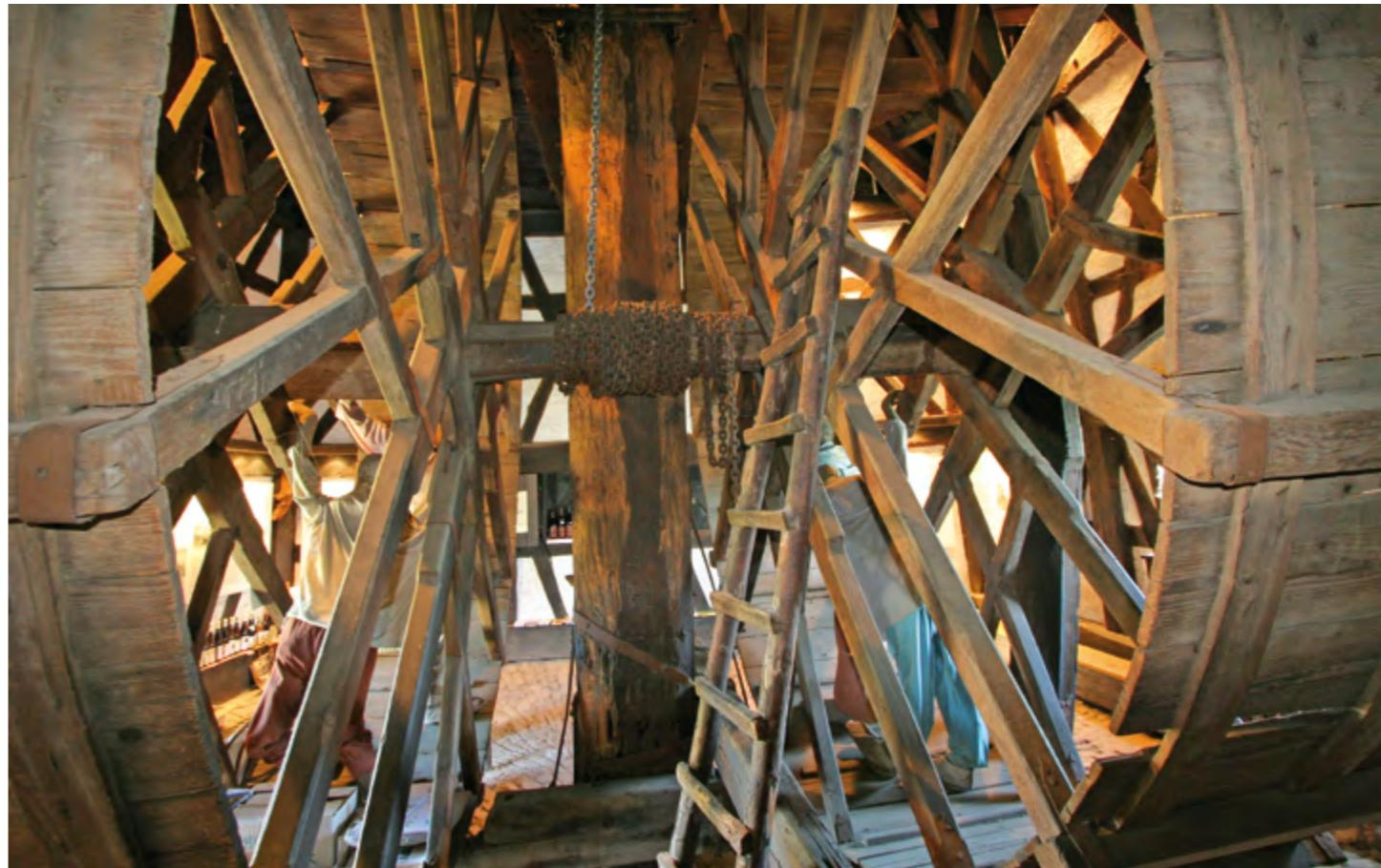
Der antike **Oestricher Weinverladekran** stammt von 1745 und wurde durch Menschenkraft in den beiden Antriebsrädern betrieben.
